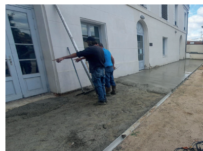
Cours du Manoir du Vieux Logis avant / après travaux : rénovation de la cour intérieure du Manoir du Vieux Logis avec réfection de la dalle qui sert de toit à la cave et de drainage.
