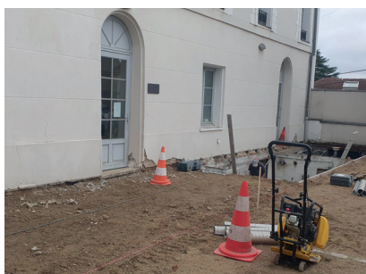
Cours du Manoir du Vieux Logis avant / après travaux : rénovation de la cour intérieure du Manoir du Vieux Logis avec réfection de la dalle qui sert de toit à la cave et de drainage.
