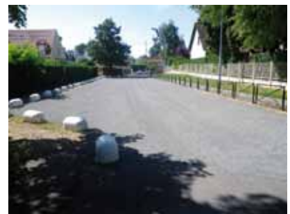
4 - Réfection du parking
